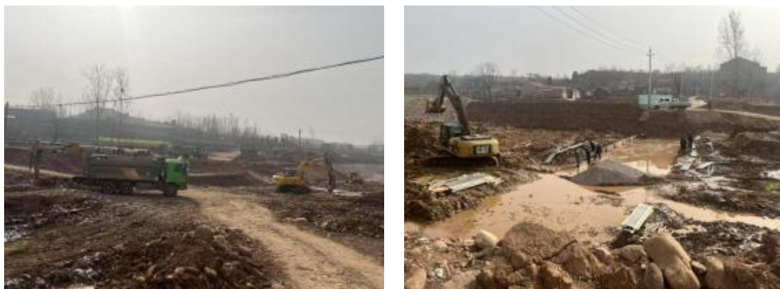
图6 涧河南岸治理段现场图
