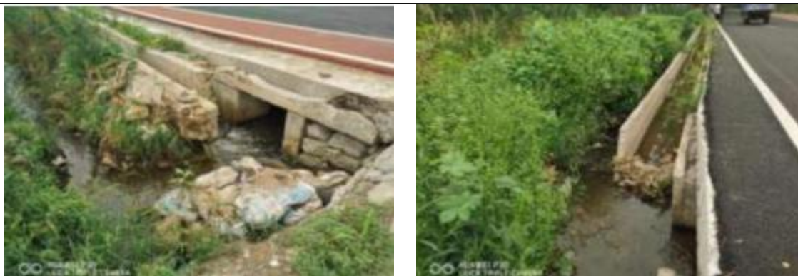
图4 涧河南岸治理段排洪渠现场图
