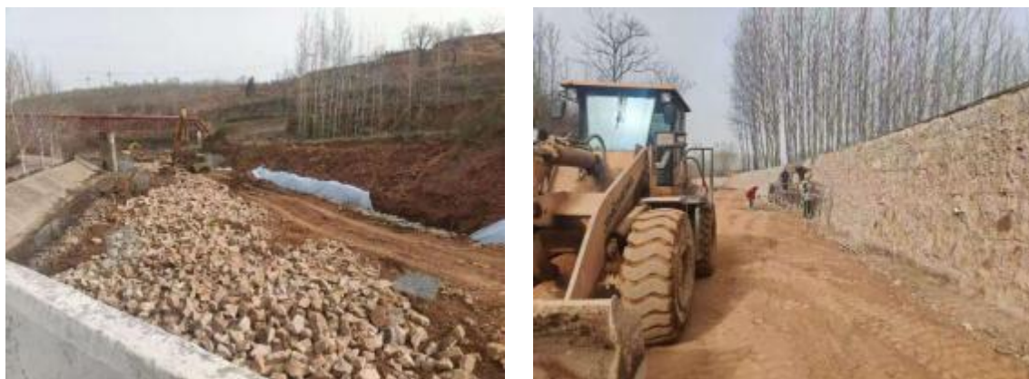
图7 燕沟治理段排洪渠现场图
